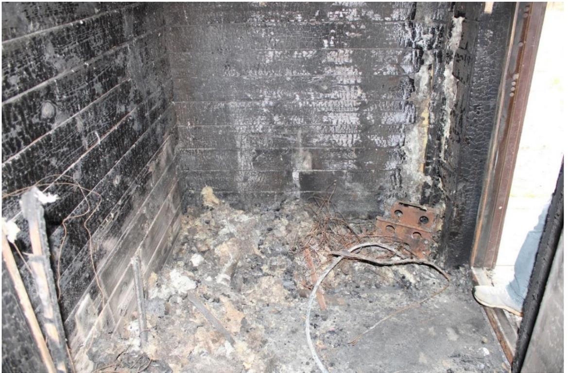
Рис. 4. Помещение, где произошло воспламенение зарядного устройства и аккумуляторного блока моноколеса
